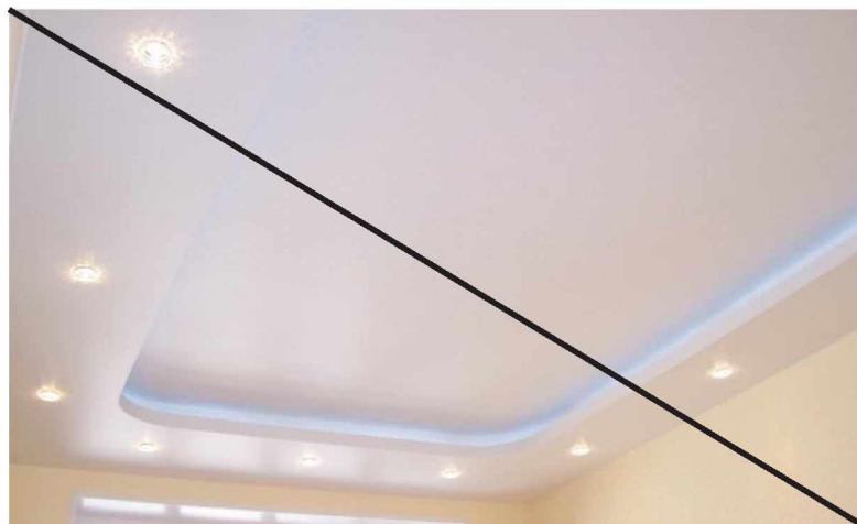
Плохо Многоуровневые гипсокартонные конструкции
